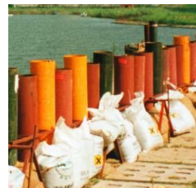
Mit Sandsäcken stabilisierter Mörtel
