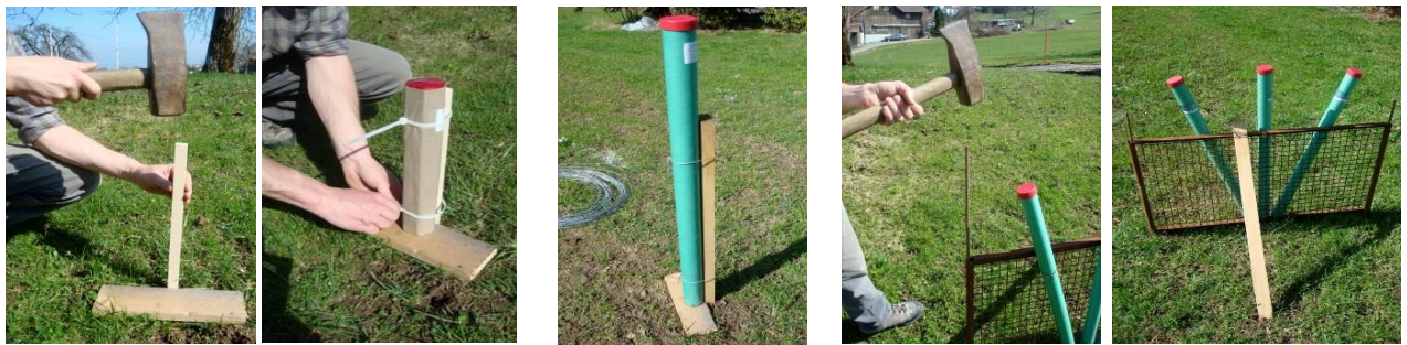
Beispiele für die Montage auf weichem Grasboden
