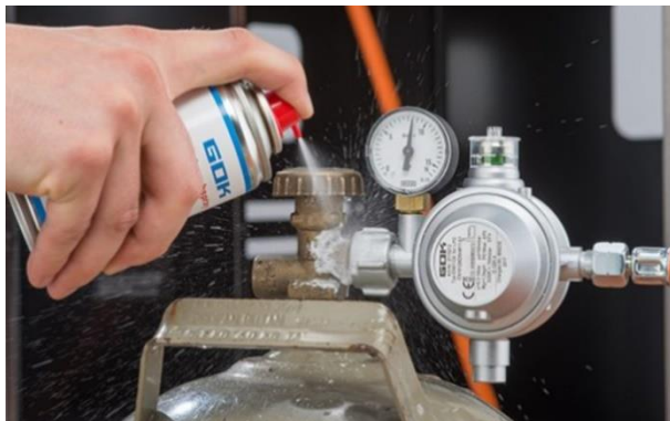
Auftragen von Prüfschaum
